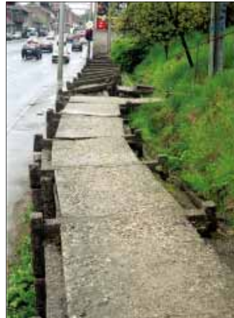
Zid uz Illicu, nasuprot zgrade MUP-a, trebao bi zaustaviti klizište, ali i sam je sve nagnutiji
