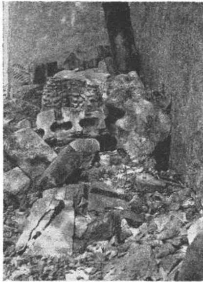
Odstranjeno kamenje iz zagrebačke katedrale. U pozadini komad zaglavnog kamena iz Marijine kapele. Karakteristična forma rebara.
