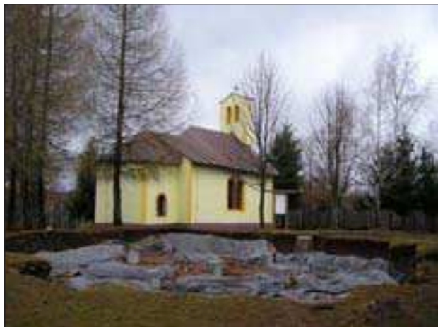
Budinjak – kapela sv. Petke, drenaža (Foto: M. Želle)
