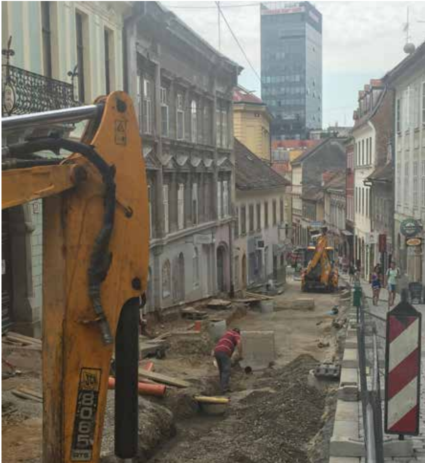
Premještanje instalacija prema Kamenitim vratima
