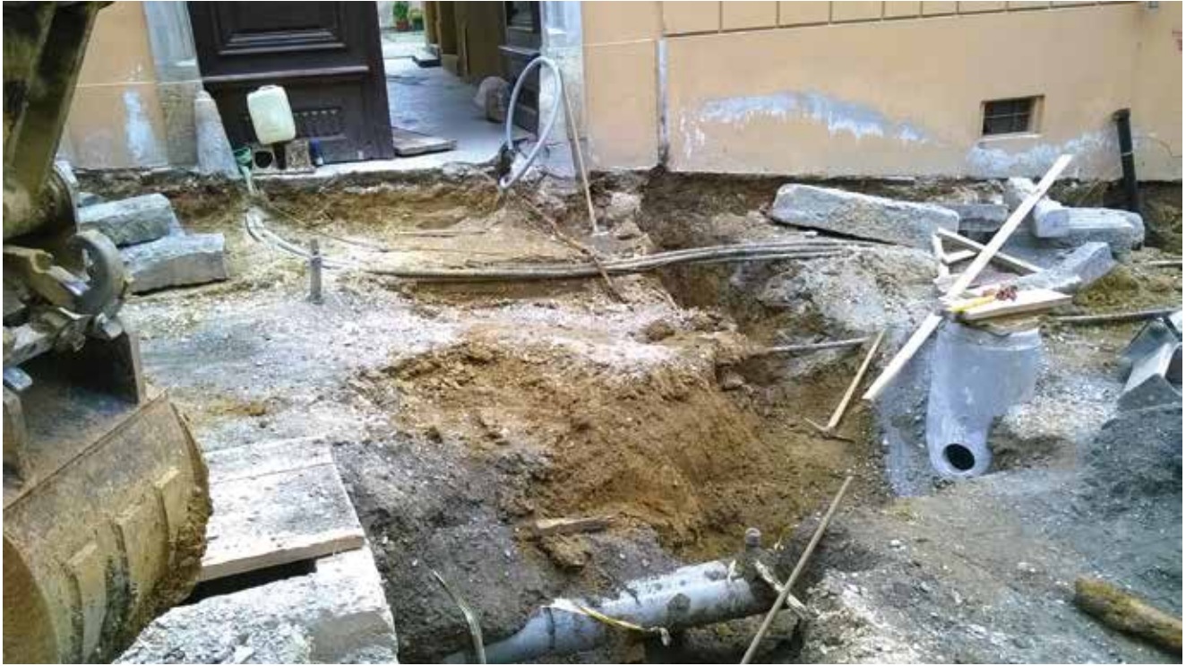
Premještanje instalacija
