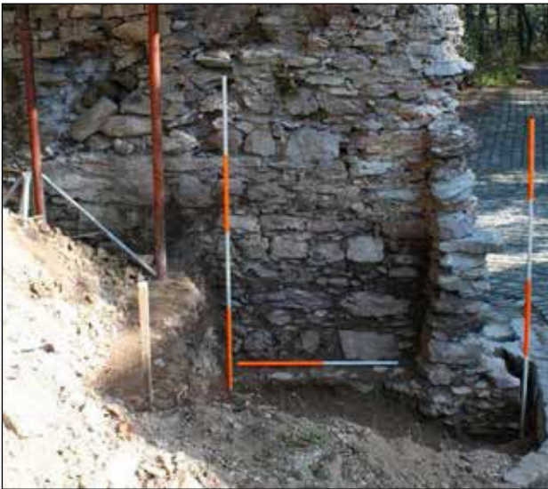
Zapadno lice obrambenog zida sjeverno od ulaza, uz današnju cestu
