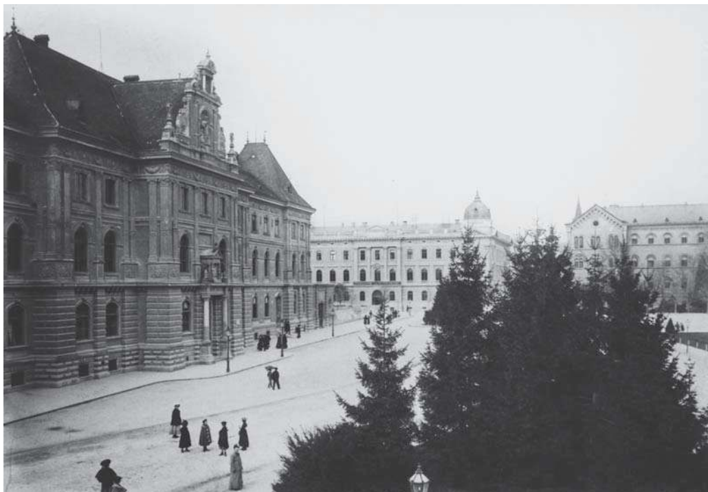
2a Herman Bollé, Pogled na Obrtnu školu i Obrtni muzej (sada Škola primijenjene umjetnosti i Muzej za umjetnost i obrt), 1888.–1892. godine, Sveučilišni trg/zapadna strana (sada Trg maršala Tita br. 10–11); fotografija izvornog stanja, snimio Julius Hühn, 1898. (Fototeka Muzeja grada Zagreba, inv. br. 9393)
