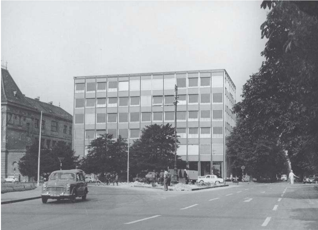
11 Stanko Fabris, Pogled na poslovnu zgradu »Željpo« – istočno – ulično pročelje, Trg maršala Tita, fotografija izvornog stanja, Jozo Vranić, 1968., vrijeme obnove HNK (fototeka Muzeja grada Zagreba, inv. br. 9952)
